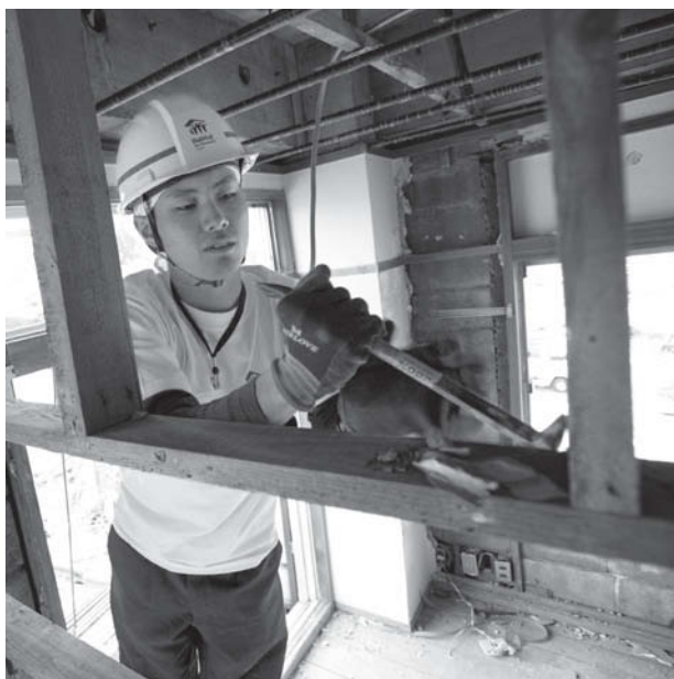
Daisuke Kaneko, voluntaria de Hábitat para la Humanidad, trabaja en el almacén de madera de un hotel en Rikuzentakata que sufrió graves daños durante el tsunami de marzo de 2011.
