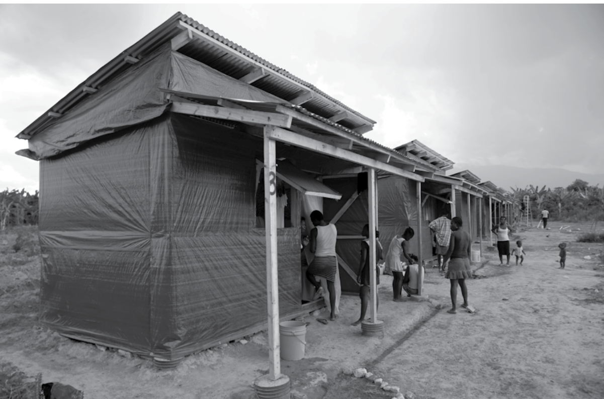
Hábitat para la Humanidad ha construido viviendas transicionales en Bercy para víctimas del terremoto. Bercy es una comunidad en Cabaret, Haití.
