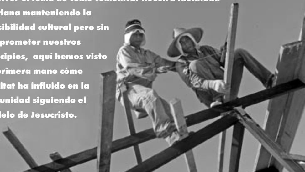
Una casa en construcción en Malasia que dará hogar a una familia más que necesita una vivienda sencilla y digna.
