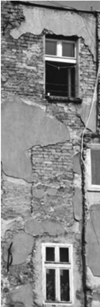
Un edificio de pisos agotados en Polonia.
