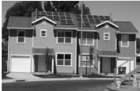
Hábitat del Este de la Bahía usa paneles fotovoltaicos lo que reduce las facturas de electricidad de los propietarios de viviendas a un valor mínimo.
