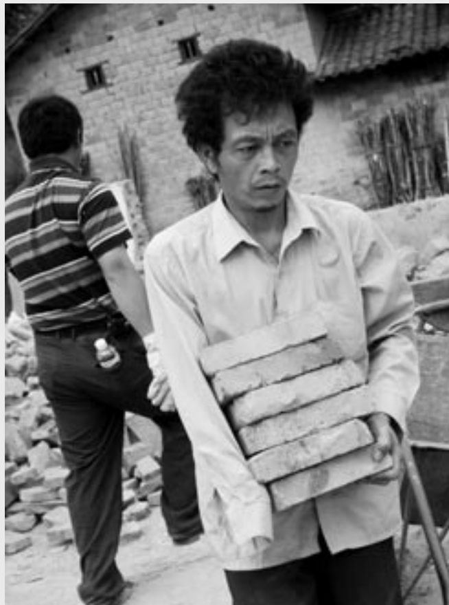
Un propietario de vivienda discapacitado del poblado de Changliu, Guandong, China, aporta sus esfuerzos para construir su casa.
