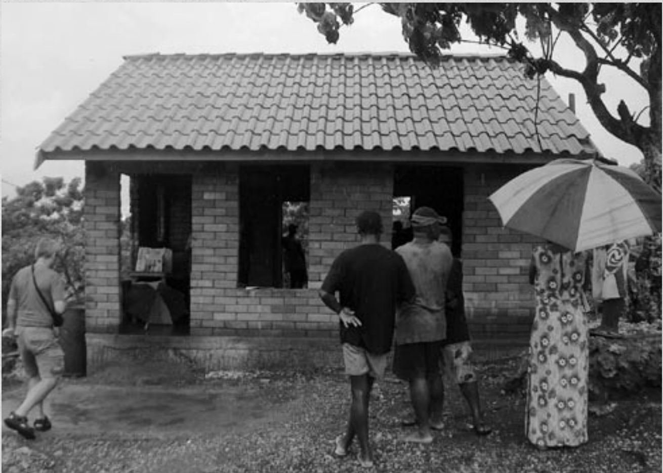
HFH Vanuatu usa losas hechas con cemento en vez de metal. Estas losas sólidas y resistentes a los huracanes se pueden fabricar en el sitio.
