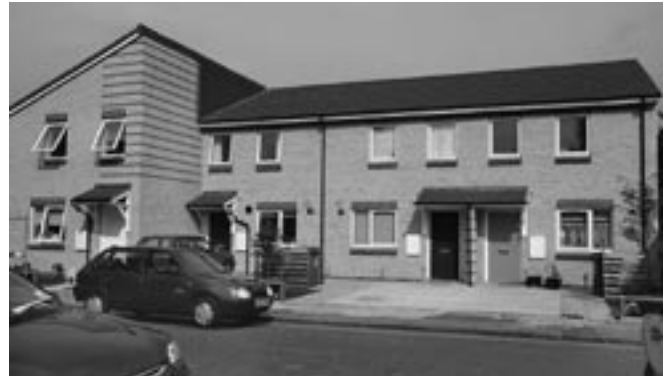
Debido a los altos costos de la tierra, HFH Southwark construye viviendas multifamiliares en Inglaterra.
