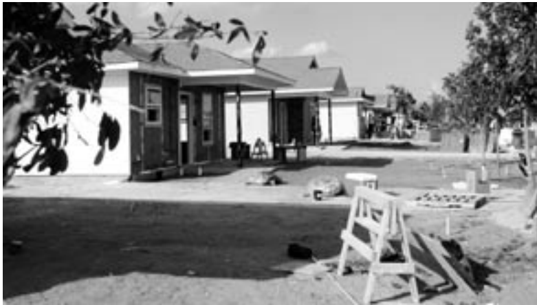
Para brindar soluciones de viviendas asequibles en el vecindario de Dallas, se construyeron 10 casas durante la Maratón de la Construcción (Build-a-Thon) AmeriCorps en 2004, organizada por HFH del área de Dallas.
