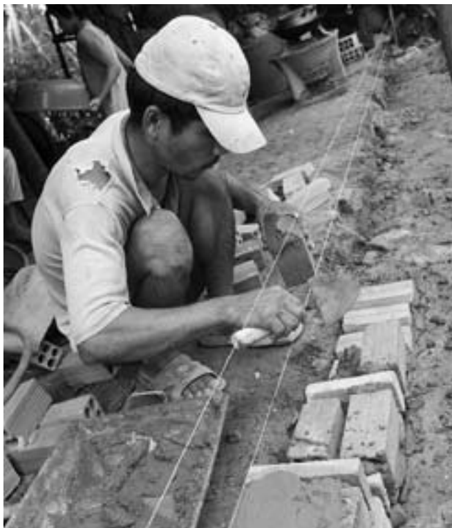
El propietario Danh Bao Long, 36, y su esposa, Huynh Thi Ly, 35, están usando su préstamo de Hábitat para poner los cimientos en la propiedad que tienen al lado de la casa donde viven ahora. La familia usará su propio dinero para el resto de la construcción. Aquí, Long coloca los ladrillos para los cimientos de su nueva casa.
