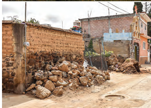
Algunos de los daños experimentados durante el sismo de septiembre 2017.
