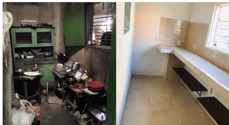
Imagen del antes y el después de un mejoramiento de cocina productiva en Paraguay.
