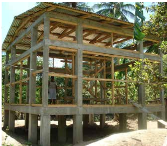
Vivienda en proceso de construcción.
