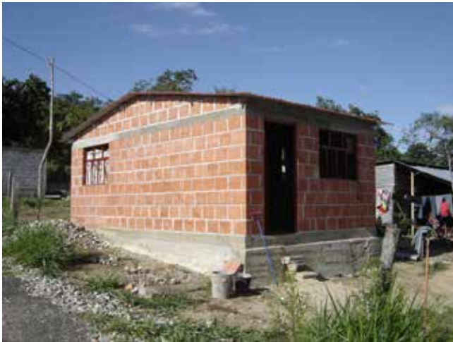
Vivienda reparada después del huracán.
