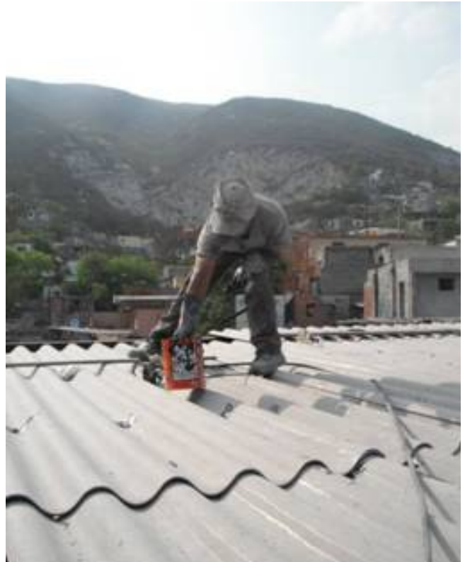
Polines y láminas nuevas en el techo.
