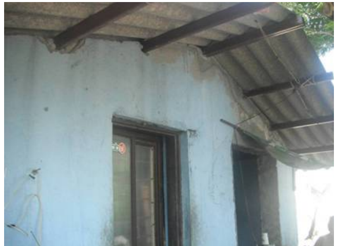
Se colocaron laminas nuevas en los techos.
