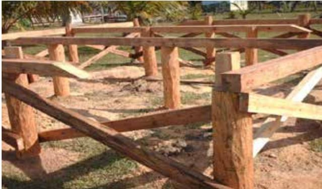
Reforzamiento de bases para montar el piso. Este era uno de los problemas identificados en la construcción tradicional donde no se empleaba ningún tipo de refuerzo entre bases.
