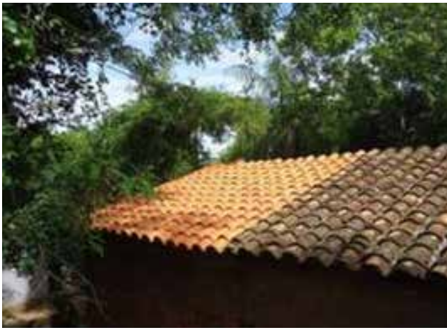
Utilización de tejas para reparar parte del techo de una vivienda afectada.
