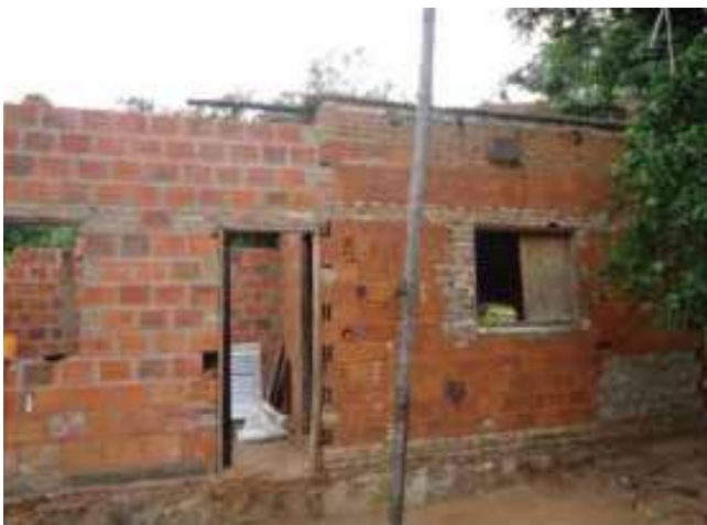
Después del temporal muchas viviendas perdieron sus techos. Tal como se aprecia se están instalando láminas metálicas en la habitación a la derecha.
