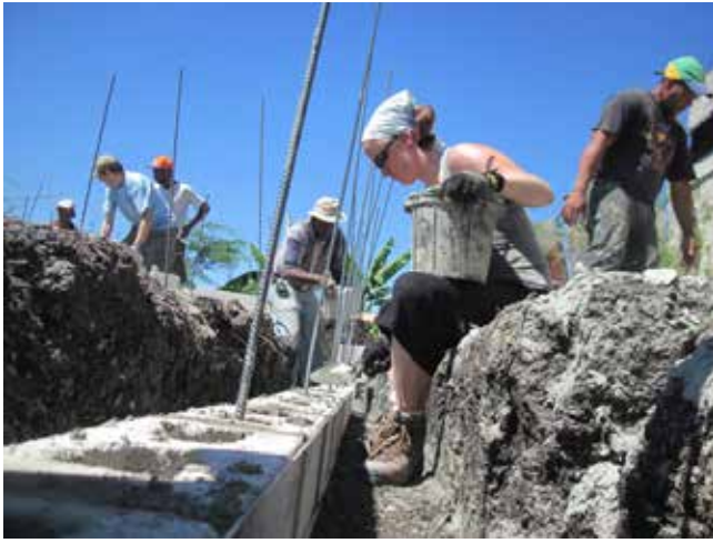
Voluntaria trabajando en los cimientos de una vivienda en construcción para una familia de San Juan de la Maguana.
