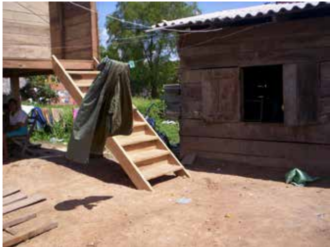
A la derecha, la vivienda antigua de la familia beneficiaria, hacia la izquierda la vivienda tipo palafito en proceso de construcción; se puede observar la escalera de madera que da acceso a la vivienda.
