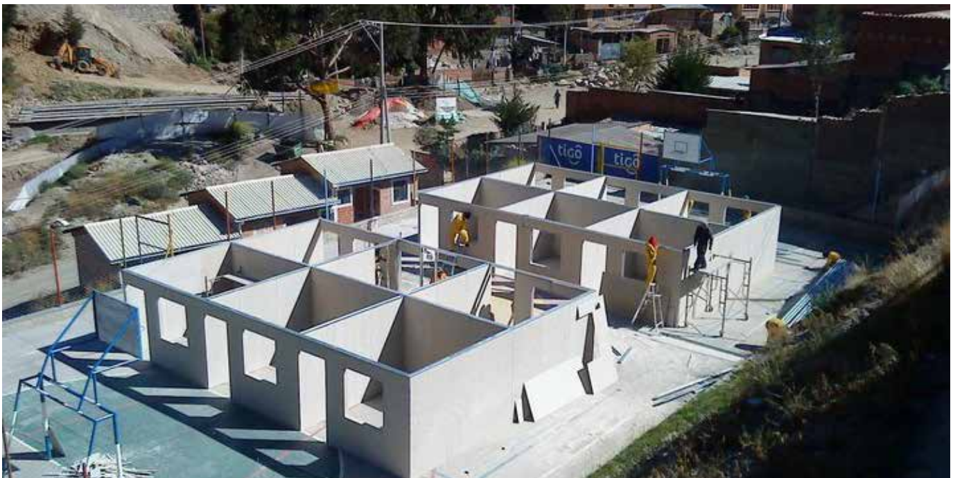
Proceso constructivo de dos módulos con capacidad para albergar a 12 familias en total. El emplazamiento se realizó en las canchas multifuncionales de los barrios próximos.
