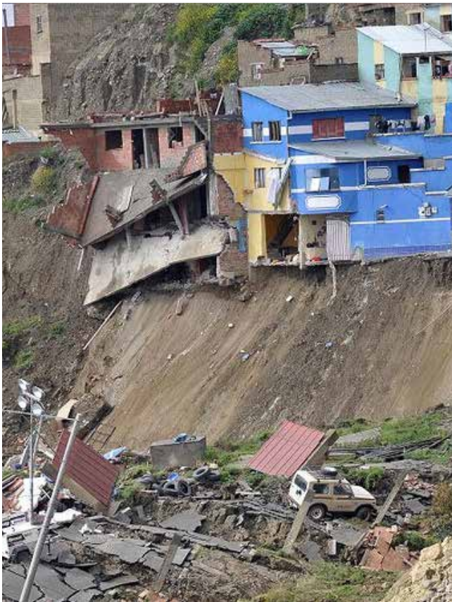
Fotografía del impacto ocasionado por el deslizamiento de Pampa Hasi en el año 2012.
