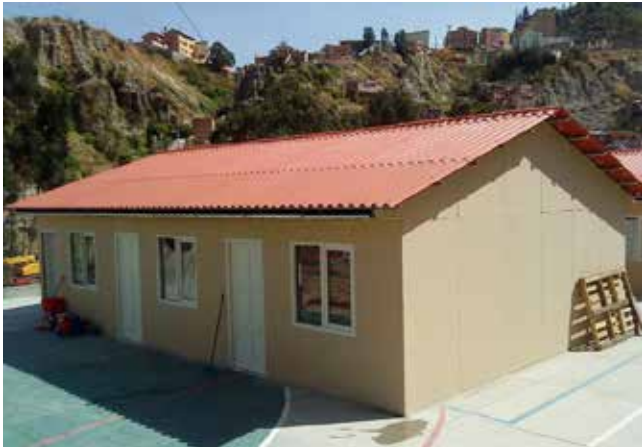
Módulo de alojamiento transicional terminado. Este módulo tiene la capacidad de albergar a 6 familias.
