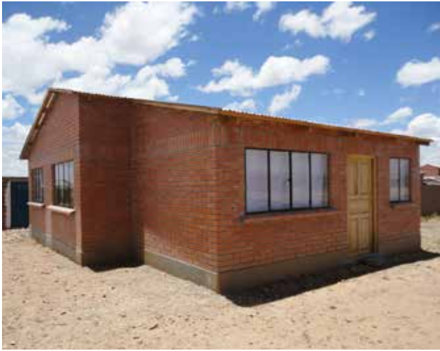
Vivienda concluida del proyecto COMPASSION, con una superficie construida de 60 m 2 . Cuenta con tres dormitorios, cocina, baño y sala comedor.
