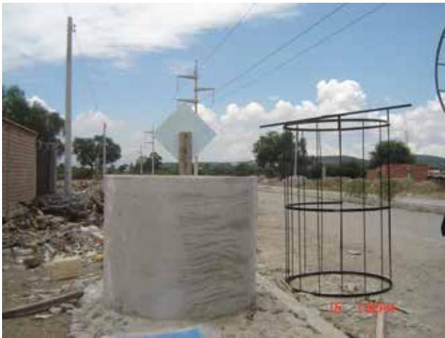
Anillo de cemento asentado sobre una superficie impermeable y estructura metálica para colocar encima de esta.
