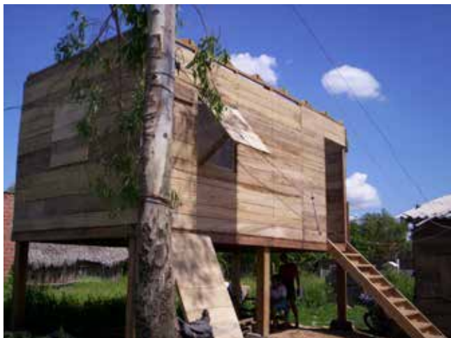
Proceso constructivo de la vivienda tipo palafito con la estructura de la vivienda lista para recibir la cubierta.
