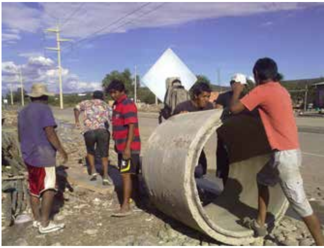
Familias beneficiarias de los campamentos temporales aprestándose para la construcción del baño seco.
