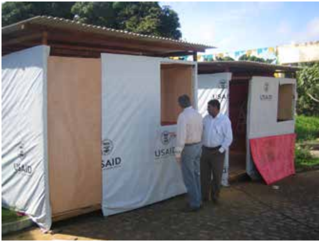
Alojamiento transicional en Agua Preta.
