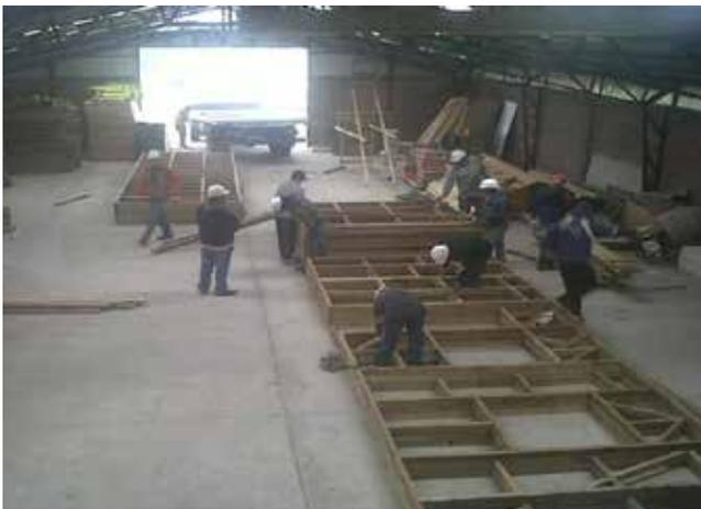
Construcción de paneles para muros de las viviendas en el taller de Paine.
