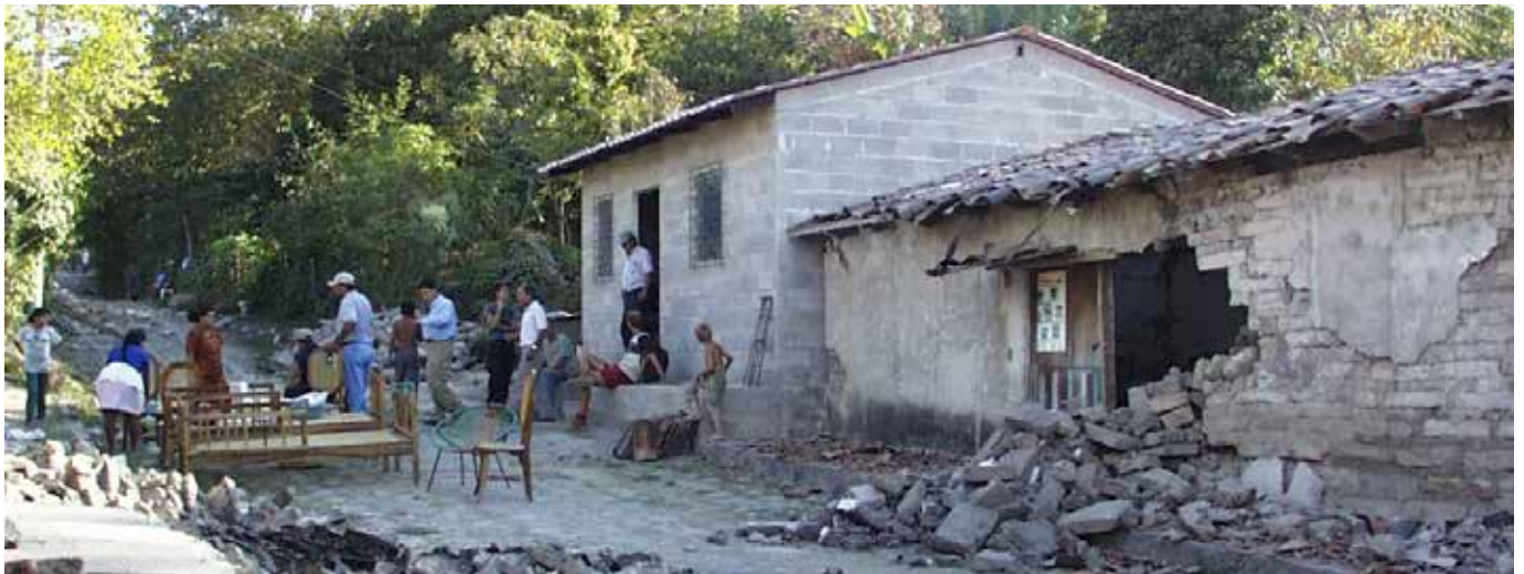
El diseño técnico de las viviendas de Hábitat fue modificado para construir casas nuevas con mayor resistencia a terremotos mayores.
