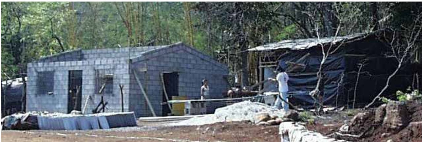
Se construyeron un total de 619 viviendas nuevas.
