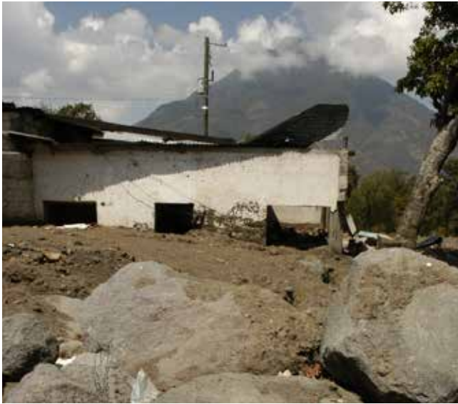
Afectaciones en viviendas a consecuencia del Huracán Stán.
