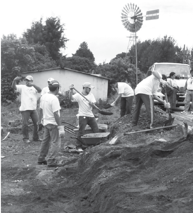
Voluntarios trabajando en las labores de reconstrucción.
