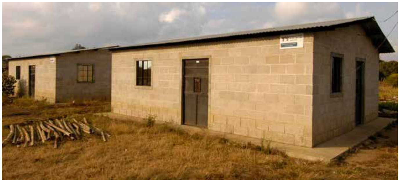
Viviendas nuevas construidas por Hábitat Guatemala.
