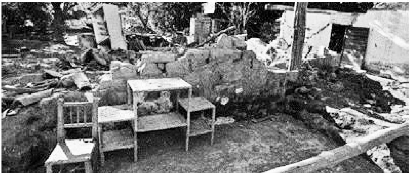
Viviendas afectadas por el Huracán Mitch.
