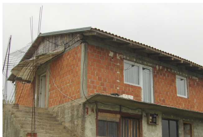
Esta casa se encuentra en proceso de mejora.
