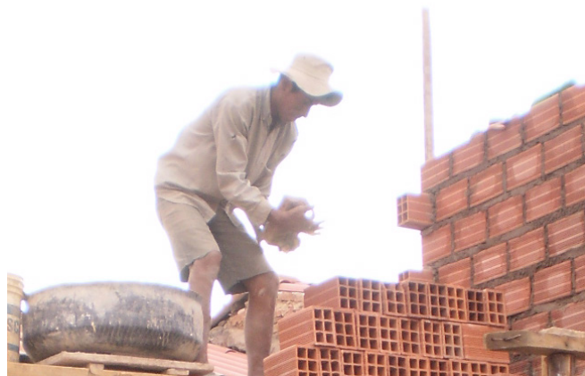
Albañiles trabajan en las mejoras de una casa en Bolivia.
